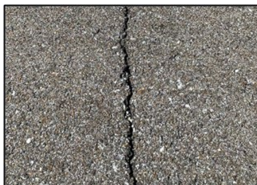
(d) Medium severity longitudinal joint crack
