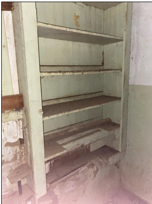
Figure 115. Wooden shelf in the World War II-era bathroom of the José María Gil Adobe, 2021. (ERDC-CERL.)
