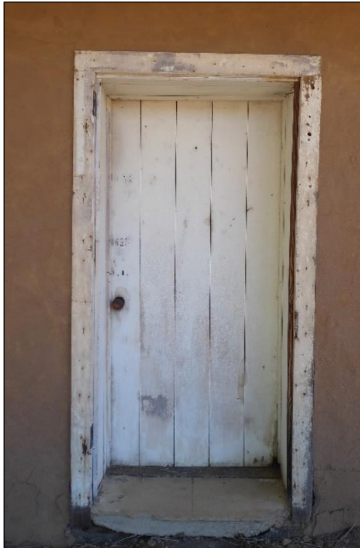
Figure 100. Main exterior door type on the José María Gil Adobe, 2021. (ERDC-CERL.)
