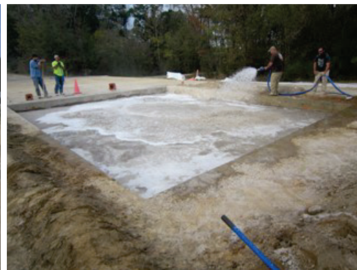
(d) Ensuring water coverage
