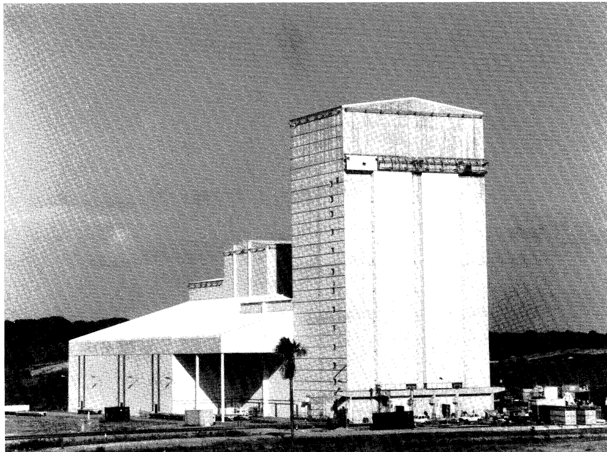
Fig. 3 : Bâtiment d'Intégration Propulseurs
