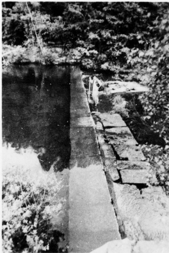
G. Spillway Crest
