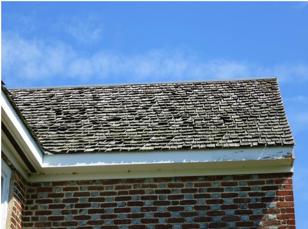
Figure 92. Wood shingles (ERDC-CERL, 2012).
