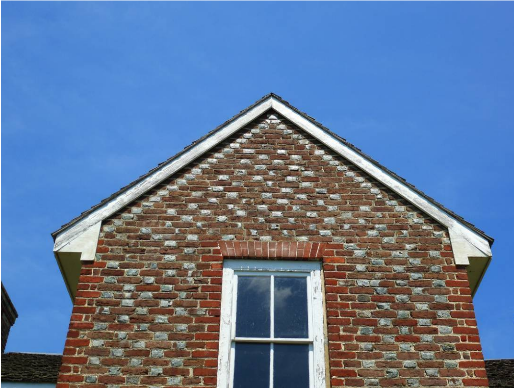
Figure 24. Wood rakeboard and soffit (ERDC-CERL, 2012).
