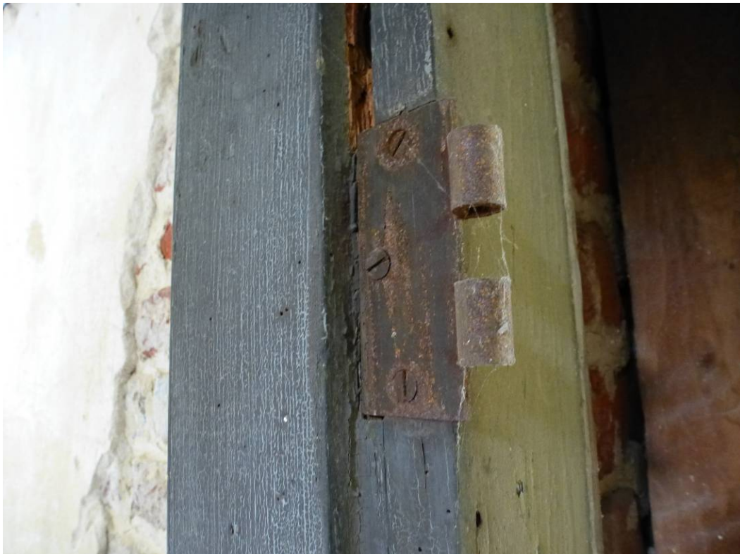
Figure 183. Rusty door hinge (ERDC-CERL, 2012).
