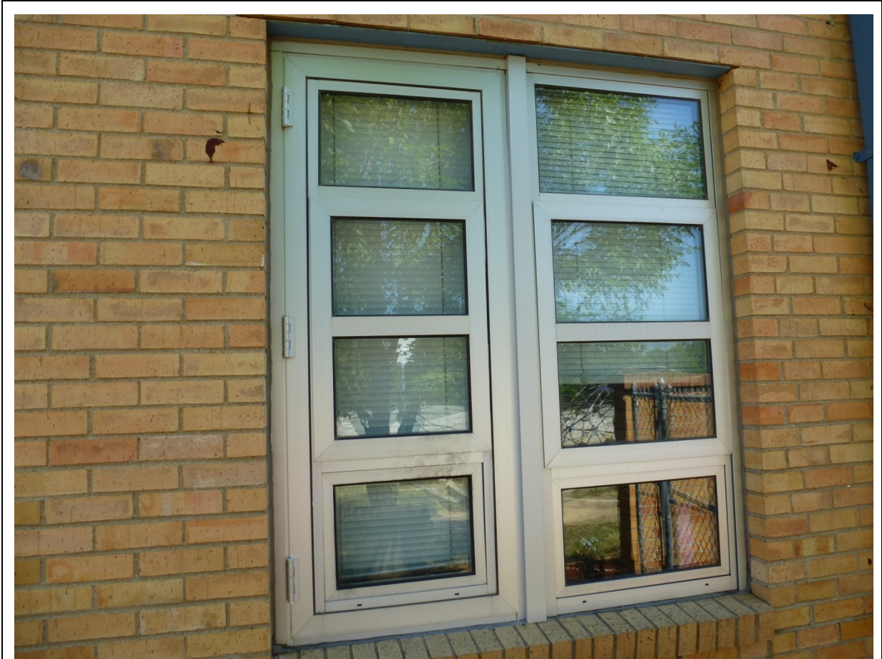
Photo 25. Replacement bright aluminum egress windows (ERDC-CERL, 2012).
