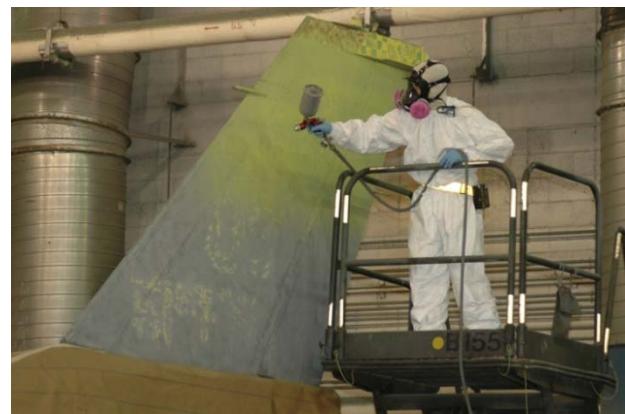
Barrier coat encapsulates chrome primer Chrome primer application on F-16
