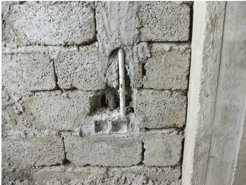
Site Photo 55. PVC conduit and electrical box
