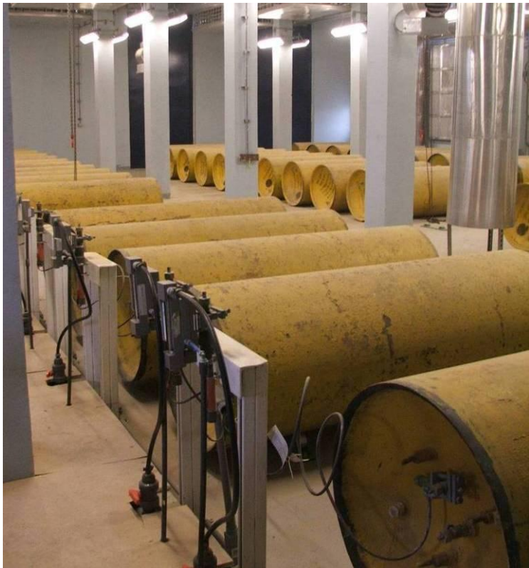
Site Photo 24. Chlorine cylinders
