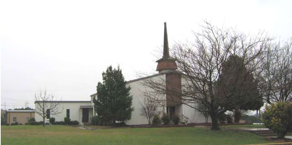
Figure 174: Killeen Base chapel #91074 (ERDC-CERL, 2004).
