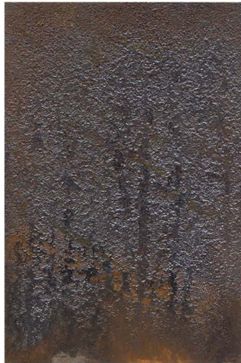
(d) CorrosionX General
