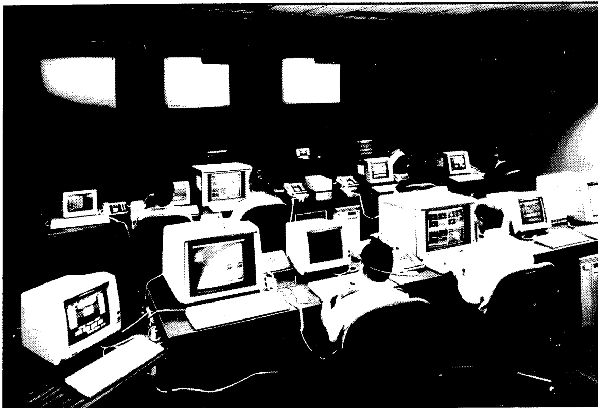
FIGURE 4.1-8 SIE Control Center
