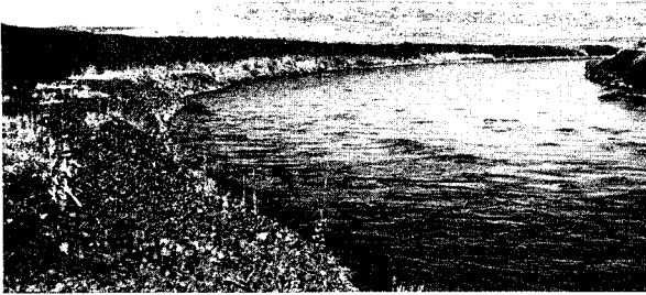
a) Existing Dike
