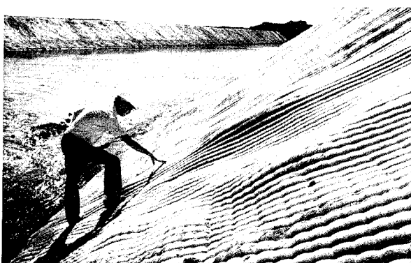
a) Existing Dike
