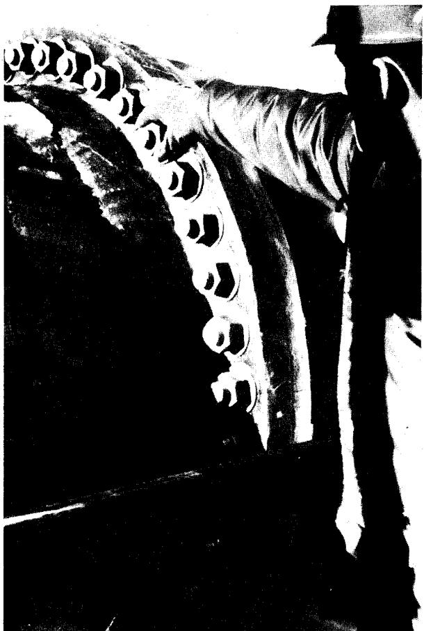
Fig. 26 : CENTRALE D'ENERGIE DE MARLEY (Etats-Unis). Les conduites en PRV sont assemblées au moyen de brides boulonnées.
