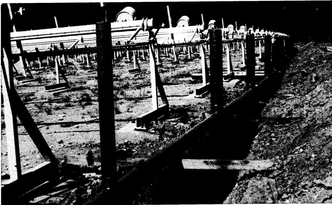
Fig. 5 : MANCHETTE D'ISOLATION EN PRV - utilisée dans l'un des projets solaires les plus importants aux Etats-Unis : le Comprehensive India Health Facility à White River, Arizona.
