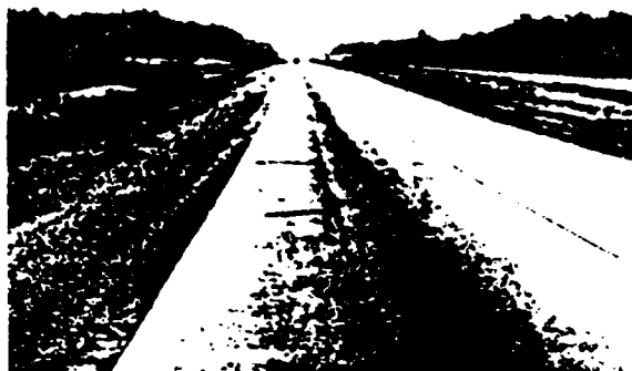
Fig. 3.2.4.1 — Longitudinal cracks
