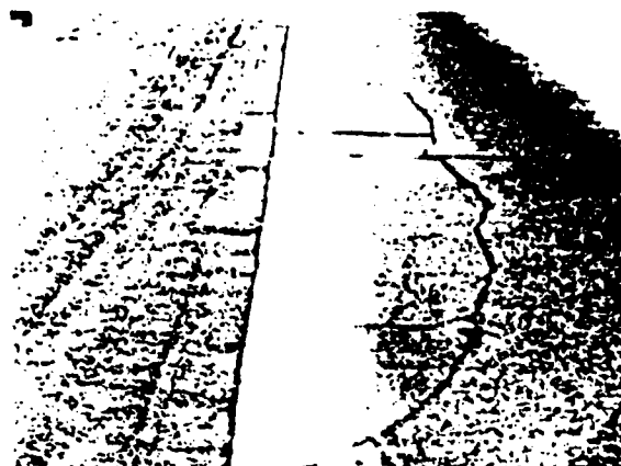
Fig. 3.2.4.7 — Edge crack
