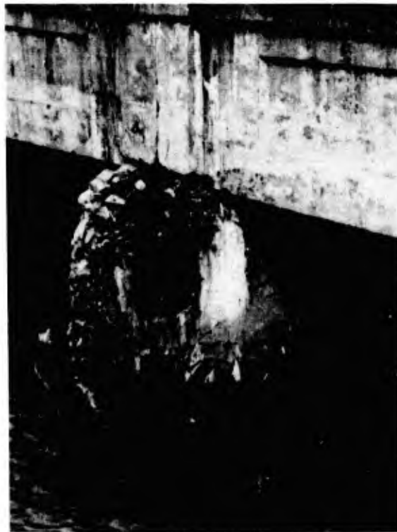
Fig. A.2.1—Disintegration
