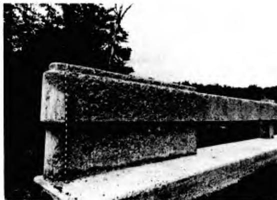
Fig. A.2.9.4.b—Scaling severe
