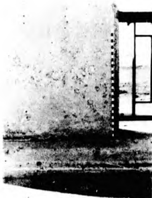
Fig. A.2.9.2.a—Scaling (light)
