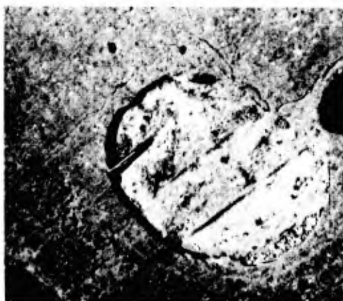
Fig. A.2.10.2—Large spall
