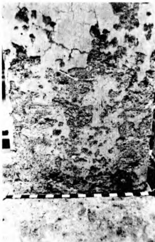
Fig. A.2.9.3.a—Scaling (medium)
