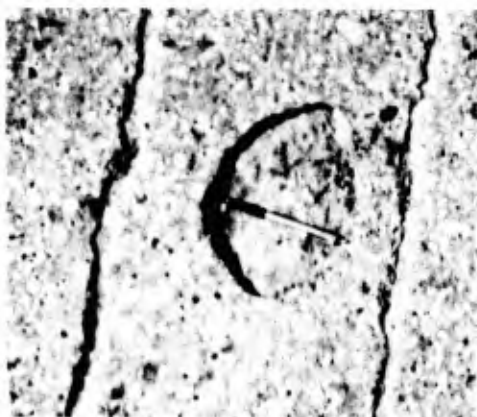
Fig. A.2.10.1—Small spall
