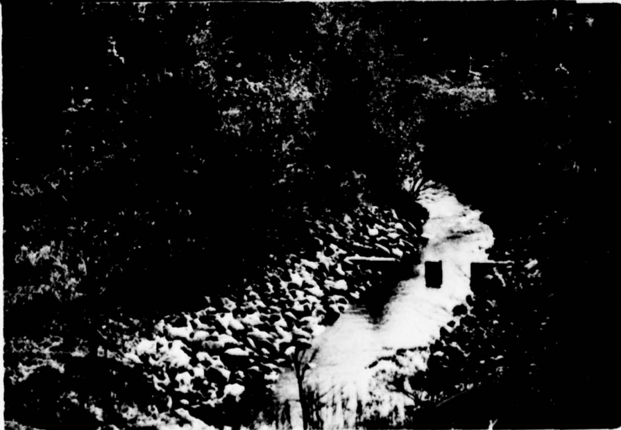
Conduit Outlet Channel
