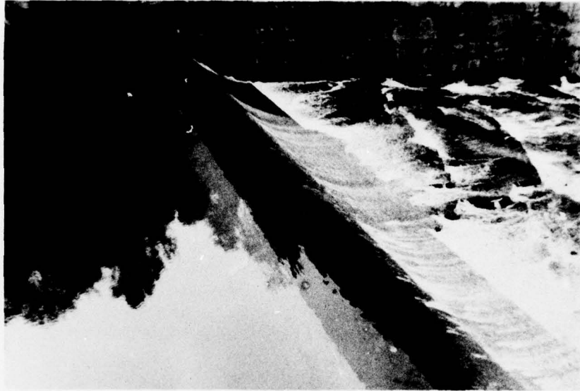
G. Concrete Spillway Weir.
