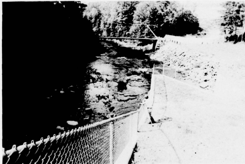
K. Downstream Channel.
