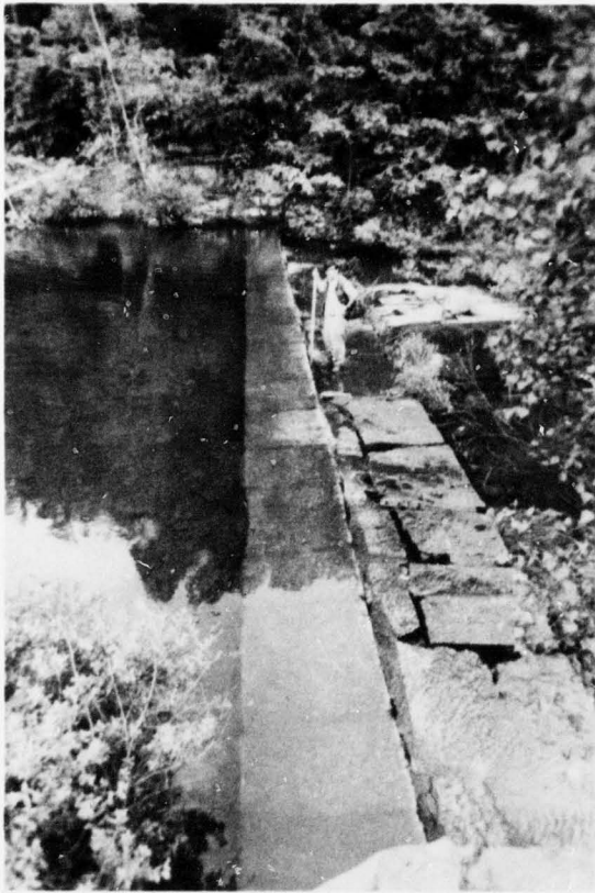
G. Spillway Crest
