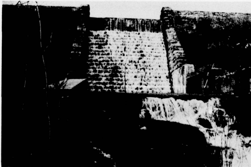
D. Spillway and Spillway Apron
