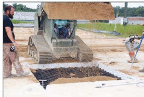
(d) Backfilling geocells with SM (Repair 7).
