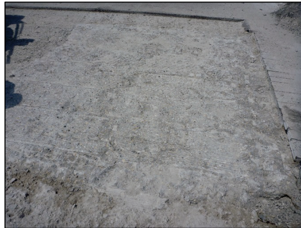
(d) 40 lb hammer, relief cuts, cold planer.
