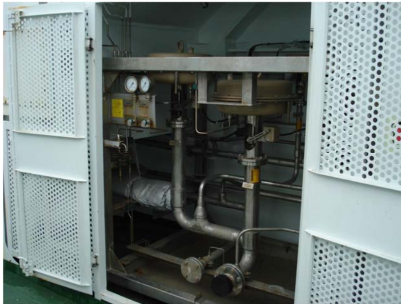
Figure C-3. Shipboard LNG bunkering connection point.
