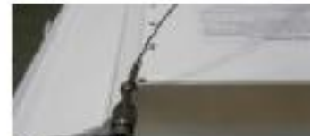
-SC- Seismic cable
