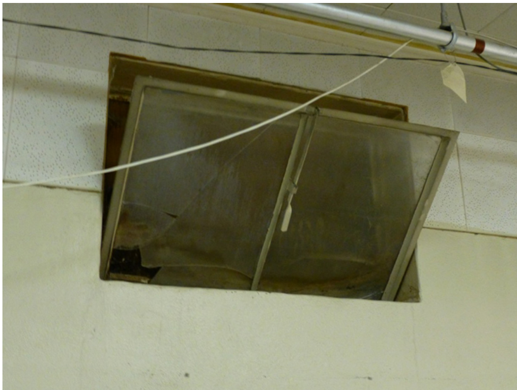
Photo 82. Laramie Armory, original metal-sash hopper window in the basement (ERDC-CERL, 2015).
