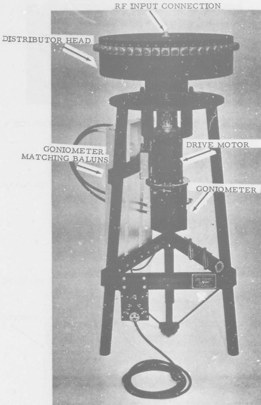
Figure 5. ASSEMBLY OF TYPICAL SINGLE SIDEBAND DOPPLER VOR DISTRIBUTOR
